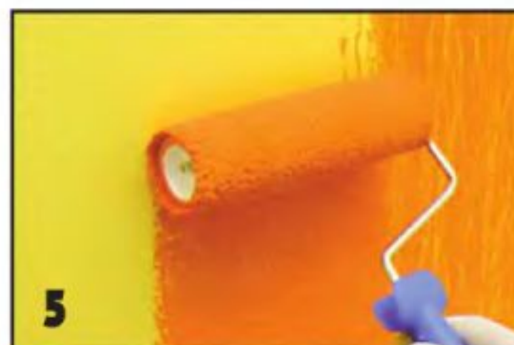
5 Без перерыва в работе покрывают краской следующий участок «заборчика». В противном случае будут видны границы между отдельными его участками.
