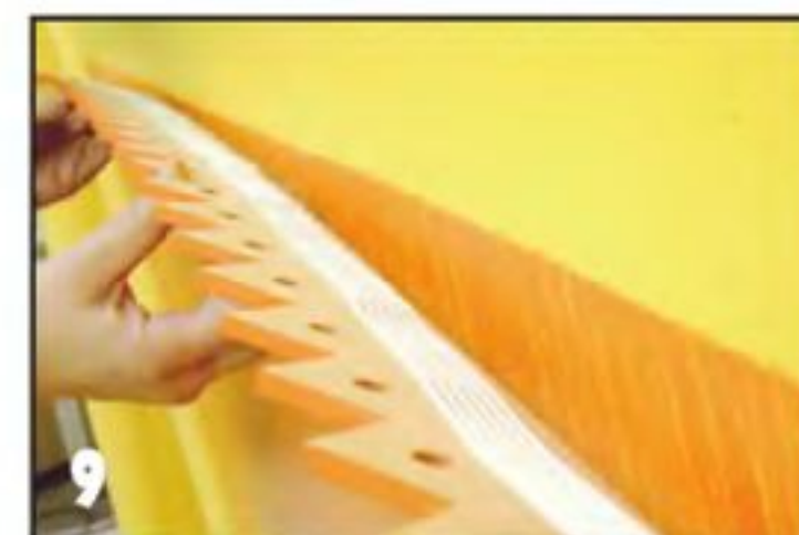
9 Используя двустороннюю самоклеящуюся ленту, прикрепляют фанерную гребёнку к стене. В результате проделанной работы стена теперь выглядит совершенно по-другому.
