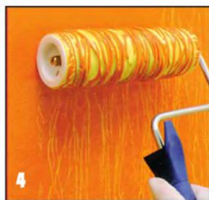
4 По сырой краске прокатывают специальным (обмотанным бечёвкой) валиком. Основа просвечивает через разогнанные места свеженанесённого покрытия и придаёт «заборчику» объёмность.
