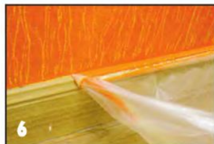
6 Сразу после окончания работы, пока краска не успела подсохнуть, снимают малярную ленту и приклеенную защитную плёнку, предохраняющую от попадания краски, например, на напольное покрытие.
