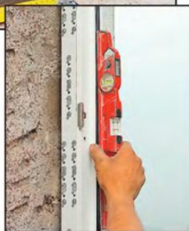
7 Контролируют уровнем положение рамы в проёме и при необходимости выставляют её деревянными клиньями или заменой подкладок.
