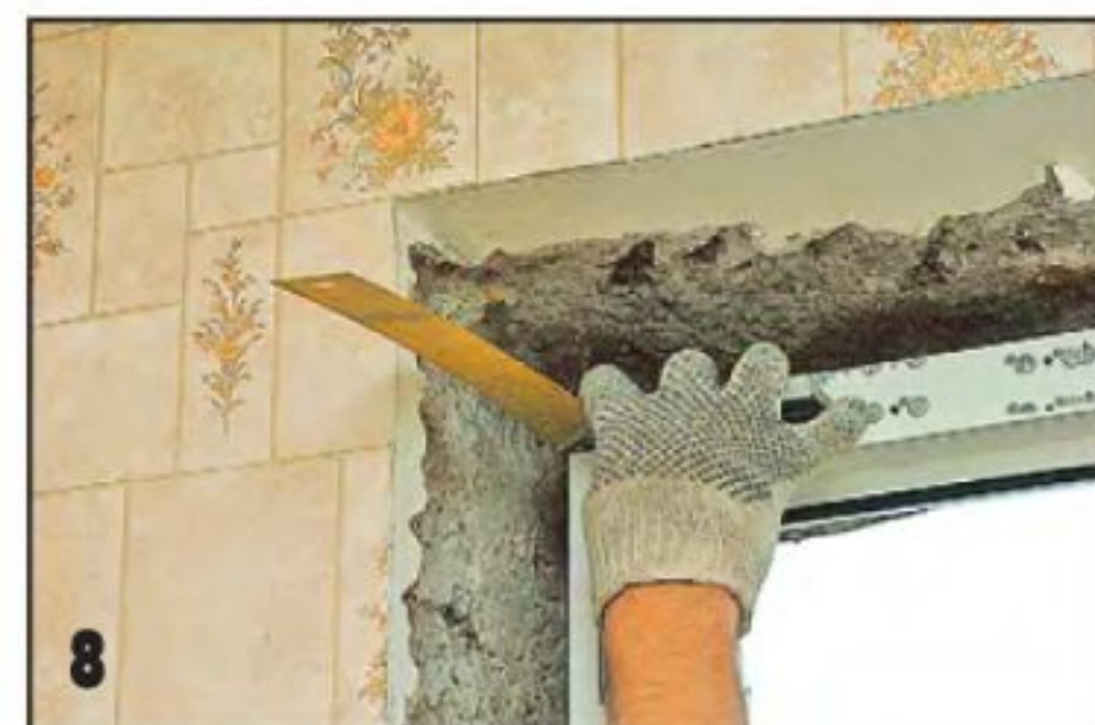
8 Перед окончательной фиксацией рамы в проёме с помощью столярного угольника проверяют, достаточно ли величина зазоров по периметру рамы для последующей установки откосов,...
