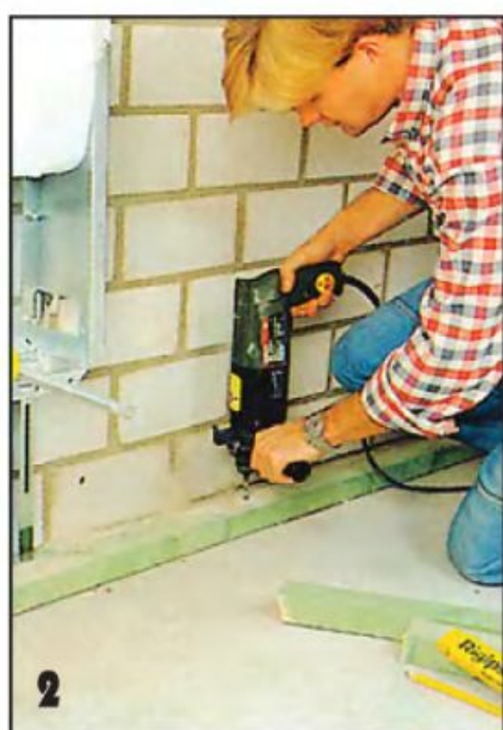
2 Каркас для экрана соорудили из деревянных брусков. Под гвоздевые дюбели просверлили крепёжные отверстия сквозь бруски.
