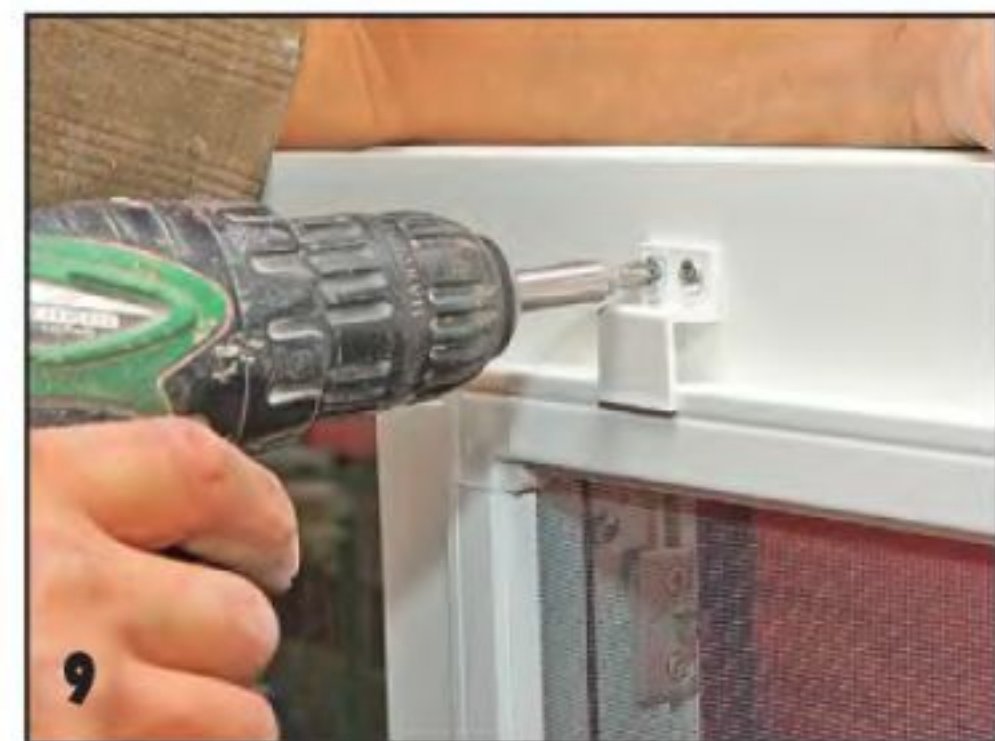
9 ...а также монтируют на оконной раме элементы крепления антимоскитной сетки, так как после монтажа сделать это будет гораздо сложнее.
