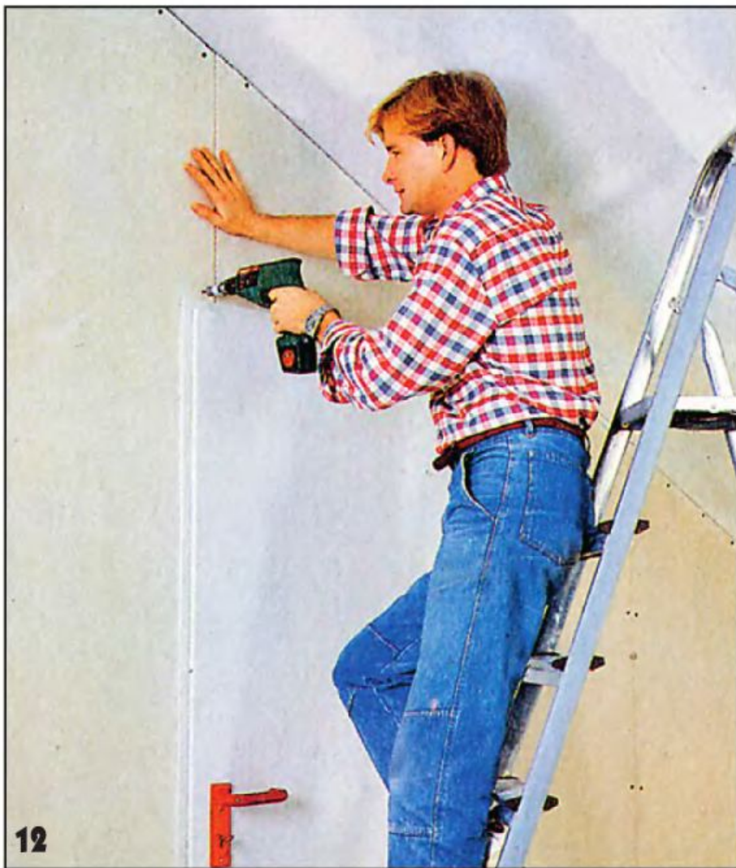
Теперь каркас можно обшить и с другой стороны. И в этом случае листы гипсокартона крепили саморезами.
