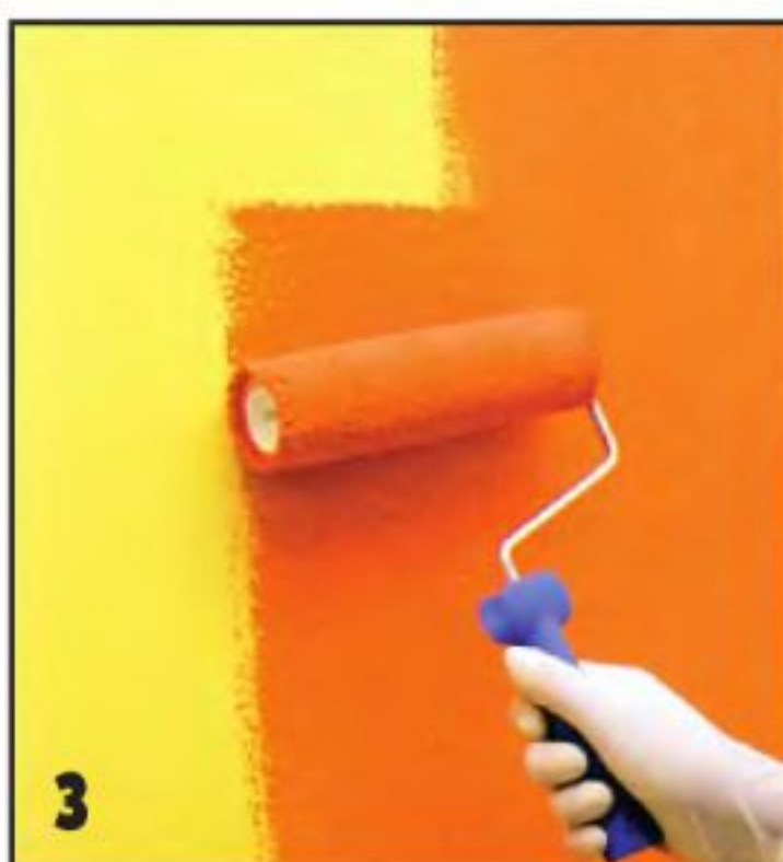
3 Обычным велюровым малярным валиком равномерно окрашивают часть «заборчика» краской выбранного цвета.
