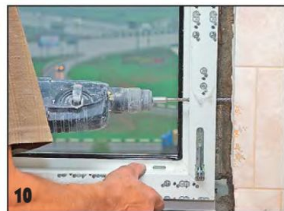
10 Просверлив отверстие в пластиковом профиле обычным спиральным сверлом, меняют последнее на бур и сверлят отверстие под дюбель в стене, используя отверстие в профиле рамы в качестве кондуктора.
