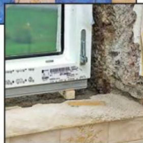
6 Оконную раму вставляют в проём, подложив снизу у краёв две деревянные подкладки толщиной 20 мм.
