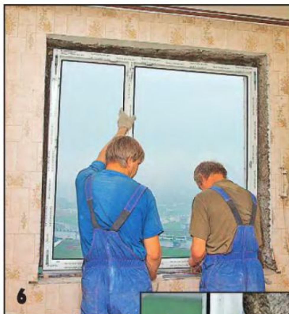
6 Оконную раму вставляют в проём, подложив снизу у краёв две деревянные подкладки толщиной 20 мм.
