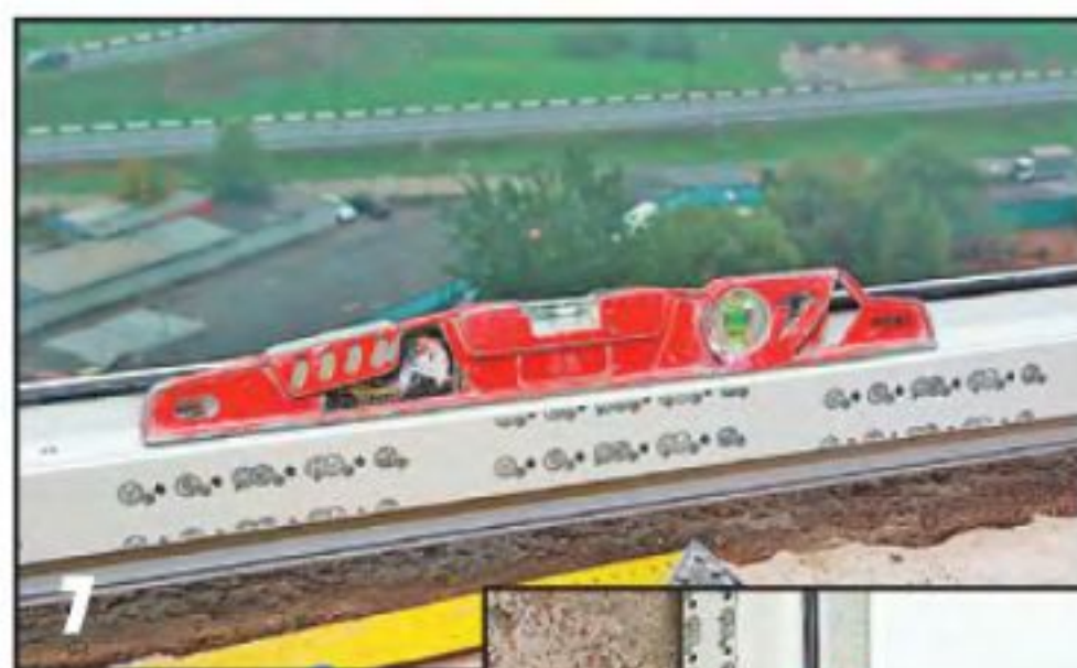
7 Контролируют уровнем положение рамы в проёме и при необходимости выставляют её деревянными клиньями или заменой подкладок.
